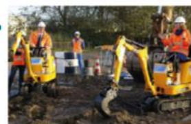
start bouw nieuwe zeesluis eind 2017
