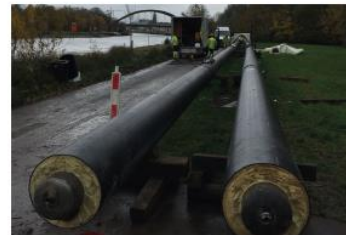
Realisatie van warmtenet tussen Imogsite en woonpark Harelbeke-Kuurne
